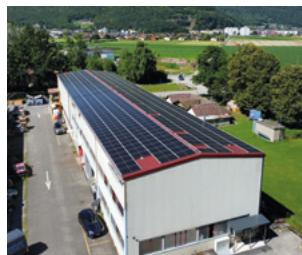
HALLE BOEUFERRANT (180.60 kWc = 52 ménages équivalent)
