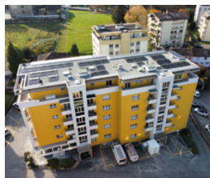
PPE LES ROSIERS (27 kWc = 8 ménages équivalent)
