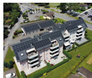
PPE LES CHARMETTES (77.77kWc = 22 ménages équivalent)
